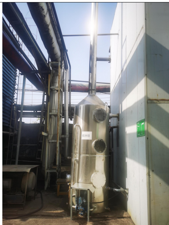
葡萄糖基甜菊糖苷酶转浓缩废气排气筒 DA021
