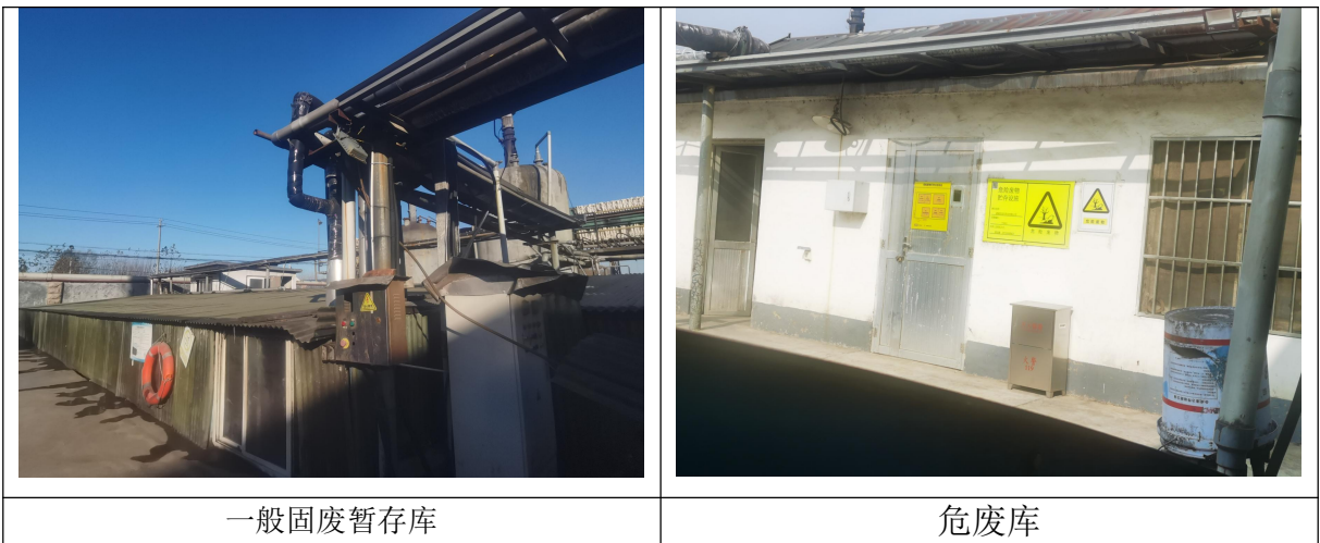
图 3-4 厂区固废存储库
