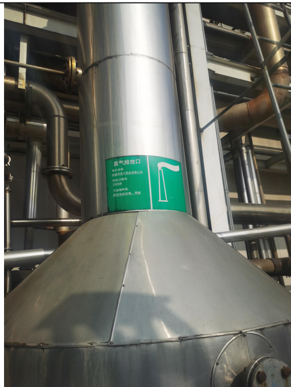
甜菊糖干燥废气二号排气筒 DA009
