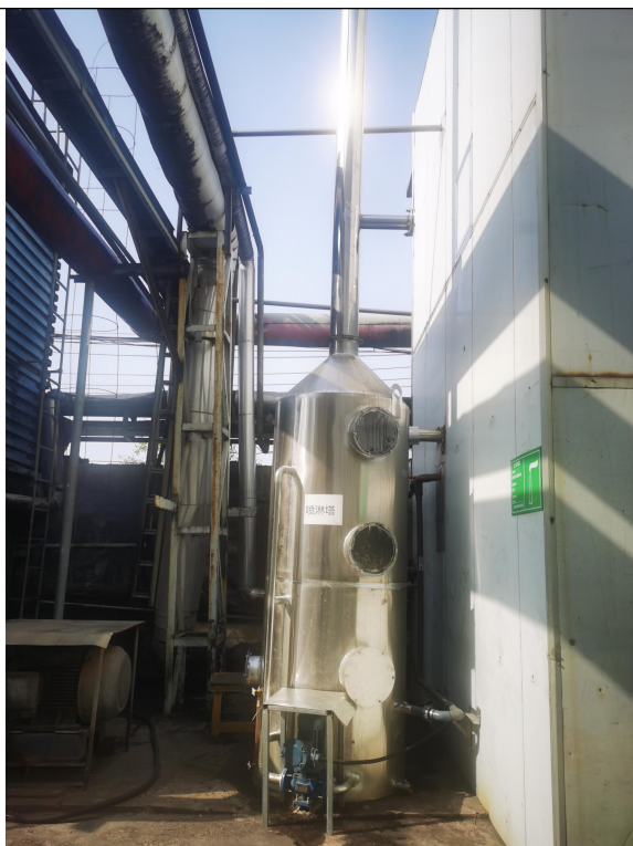
甜菊糖大喷雾干燥废气排气筒 DA015
