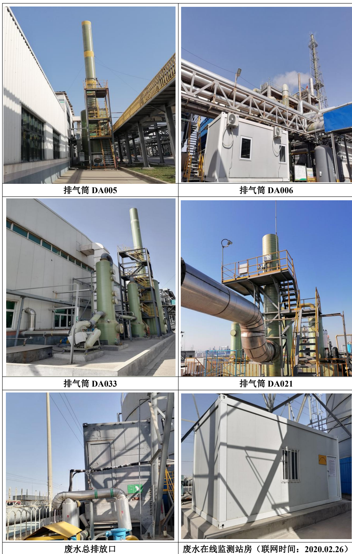
图 4.2-5 排气筒及废水总排放口照片
